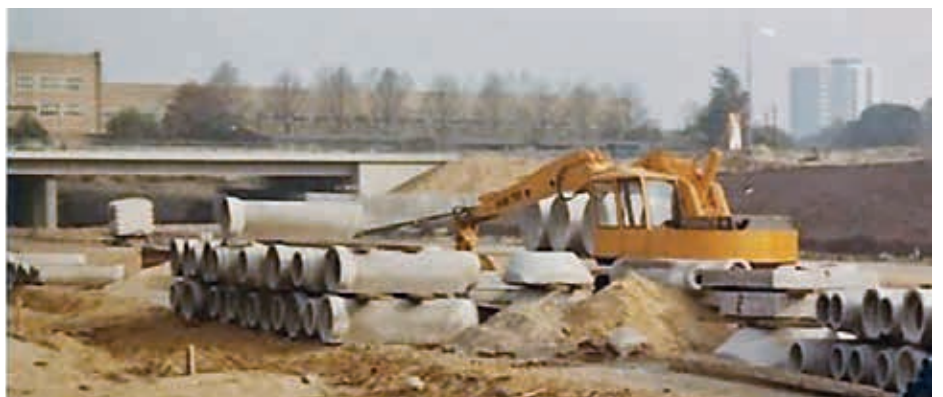
Autobahnbau, 1970 circa, Elbtunnel-Baustelle mit Christianeum und Häusern an der Sibeliussstraße Foto: Archiv Flottbek-Othmarschen e.V.
